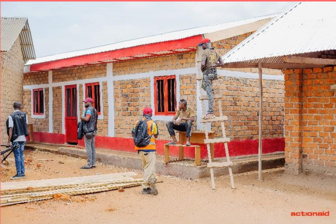
Construction en cours à l'EP Ngunda dans la communauté de Koiyitanga, Salamabila
